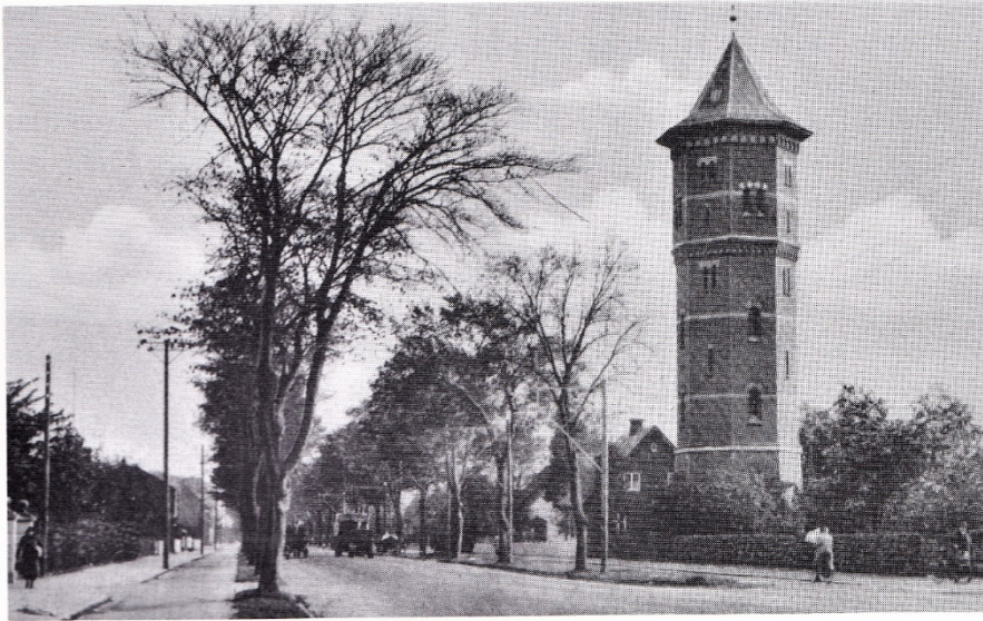
Det maleriske vandtårn har lige siden sin opførelse i 1905 været et af de vartegn, der fortæller trafikanterne på Hovedvejen, at nu er de i Glostrup. — Efter postkort fra o. 1930 i Glostrup lokalhistoriske arkiv.
