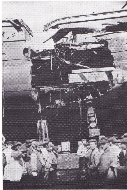
Det sunkne skoleskib "Georg Stage" blev hurtigt hævet og bragt i dok hos Burmeister & Wain. Efter reparationen tjente det som skoleskib i yderligere tre årtier. Disse to fotografier er taget i dokken kort efter katastrofen. Ved synet af den alvorlige lækage forstår man, at skoleskibet sank på et par minutter. — Billederne er velvilligst stillet til rådighed af Stiftelsen "Georg Stages Minde".
